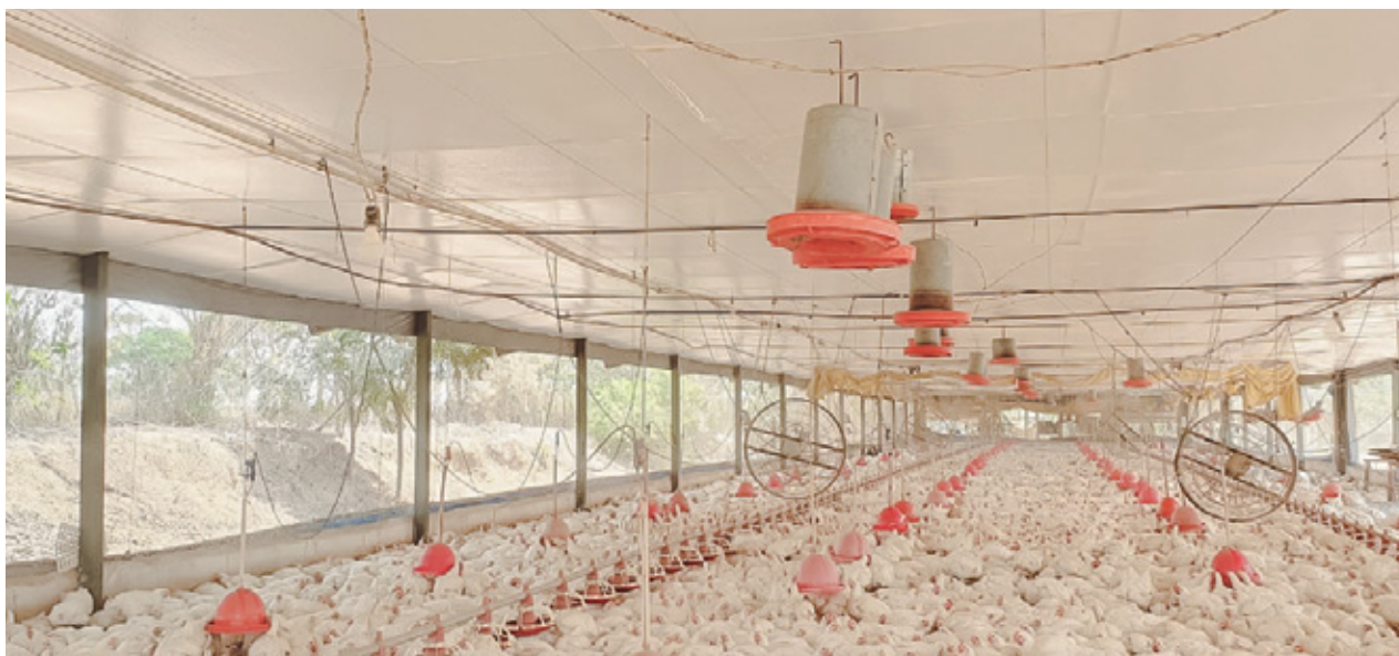
O produtos da empresa garantem eficiência térmica o conforto térmico aos aviários | Fotos: Divulgação 3TC
